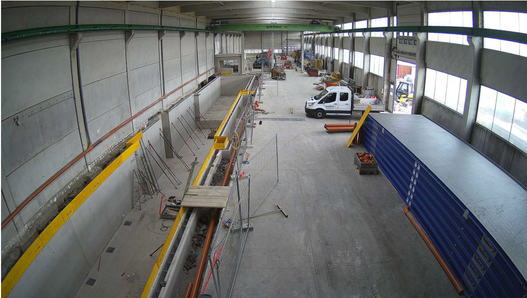
图 6 : 使用现有的建筑结构并为固化室铺设了新的地基。
